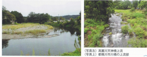
(写真左) 高麗川天神橋上流 (写真上) 都幾川市川橋の上流部
